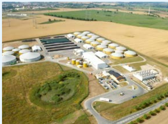
Abbildung A7-3: Biomassekraftwerk in Güstrow (Quelle: Nawaro BioEnergie AG)
